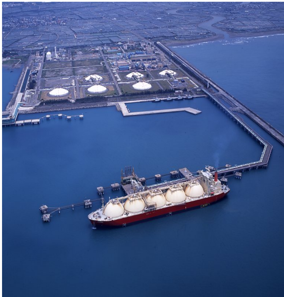
中油永安天然氣卸收站
