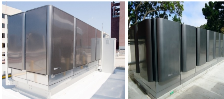
美商BE公司 SOFC發電系統
