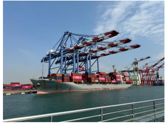
說明：認識港邊設備
